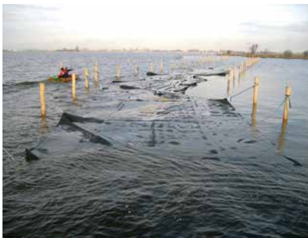
„TenCate Geotube“ sistema paruošiama pripildyti smėliu.
