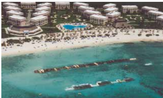
Toliau nuo kranto įrengta „TenCate Geotube®“ sistema, naudojama kaip bangolaužis
