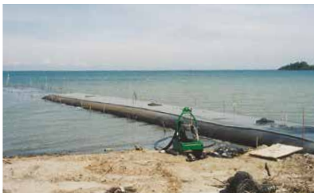
„TenCate Geotube®“ sistemos išdėstytos taip, kad suformuotų bangolaužį krevečių ūkiui.
