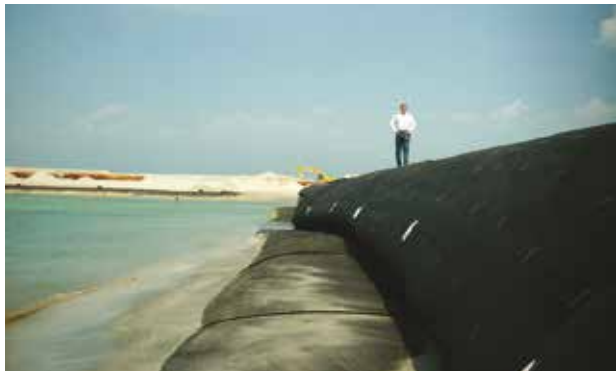
Viena ant kitos sudedamos „TenCate Geotube®“ sistemos sukuria apsauginę konstrukciją.
