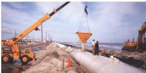
„TenCate Geotube“ sistemos smėliu pripildomos naudojant piltuvą.
